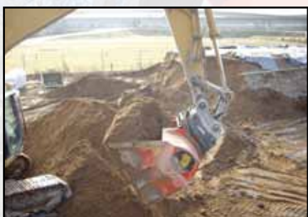
Stabilisering av bærelag
