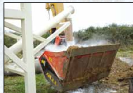
Stabilisering av jord med kalk
