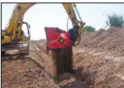
Tilbakefylling i grøfter
