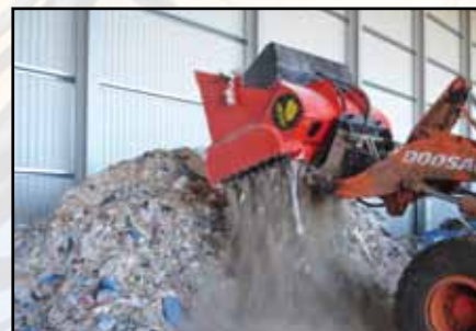
Knusing av rivningsmaterialer
